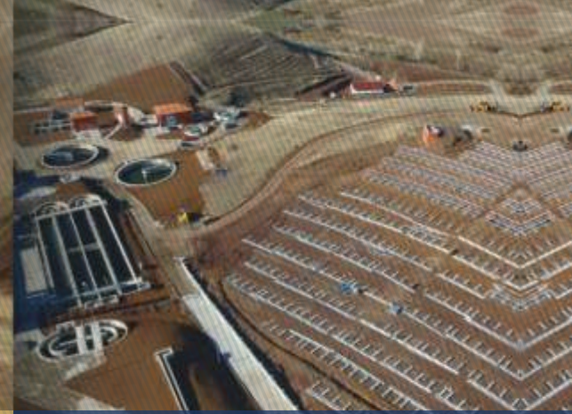
SIVRICE ARITMA TESİSİNE GÜNEŞ ENERJİSİ KURULUMU
