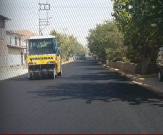
BİTÜMLÜ SICAK KARIŞIM ASFALT ÇALIŞMASI
